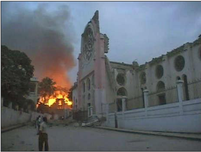
Zerstörte Kirche in Haiti
